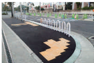
ガソリンスタンドへの斜め進入が危ないので、改善していただきました。北須磨団地入り口
